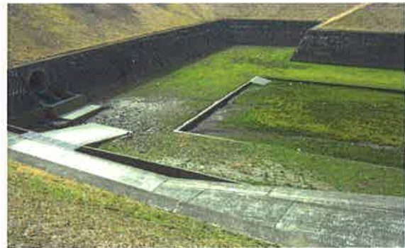
(雨水) 浸透型調整池整備の例
