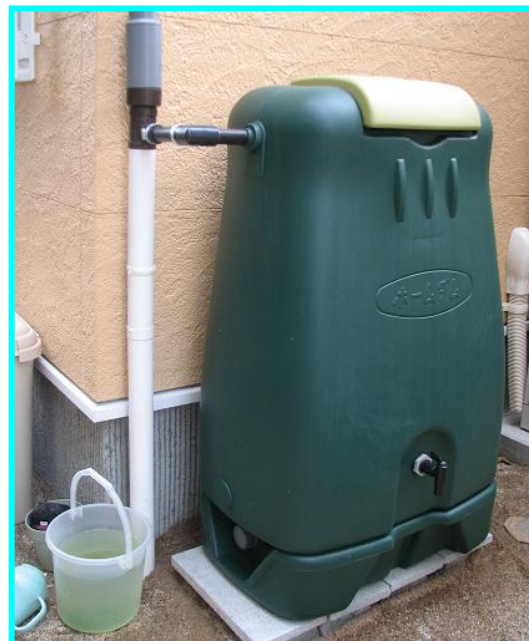
雨水貯留タンク (雨水を溜め散水・ 洗車等に利用)
